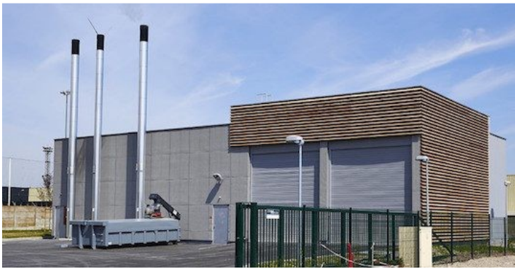
Photo chaufferie Réma'Vert, photo Engie
